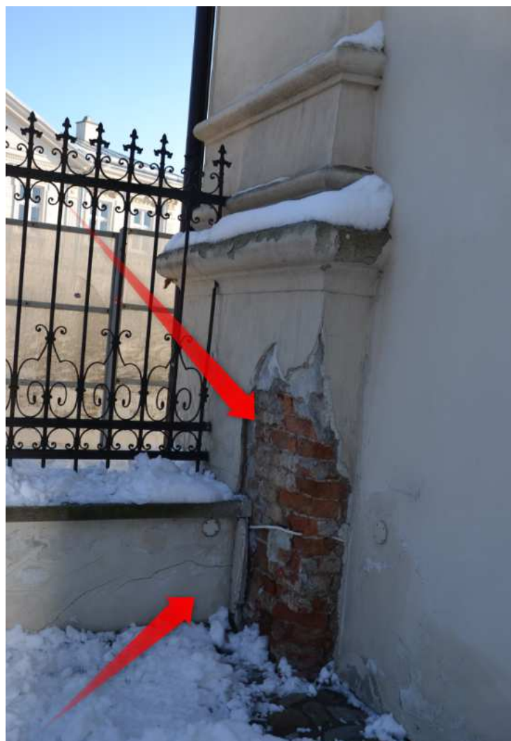
Fot. 12 Ubytki tynki i cegieł w pilastrze dzwonnicy. Odspojona farba.
