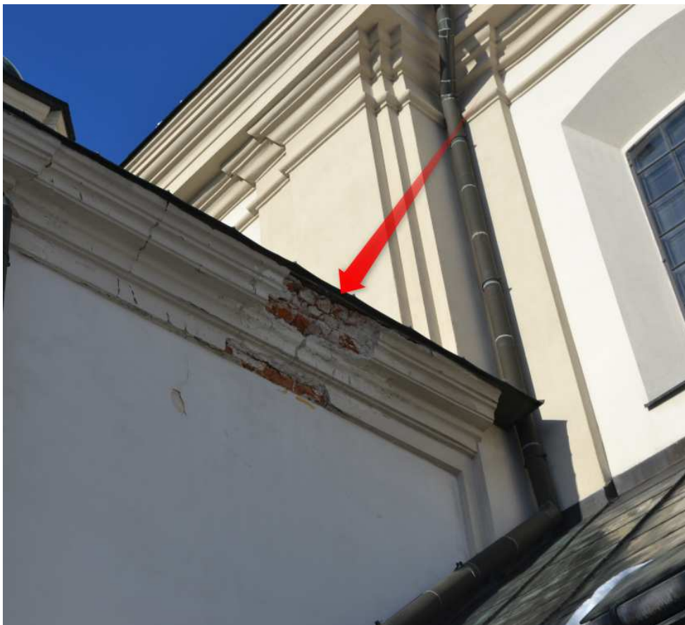
Fot. 5 Górna część kaplicy kościoła(ubytki gzymsu)
