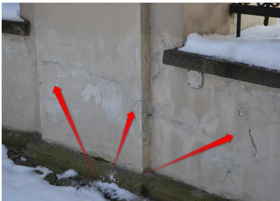
Fot. 18 Zarysowania i odparzenia tynków dolnych części ogrodzenia. Odspojona farba.
