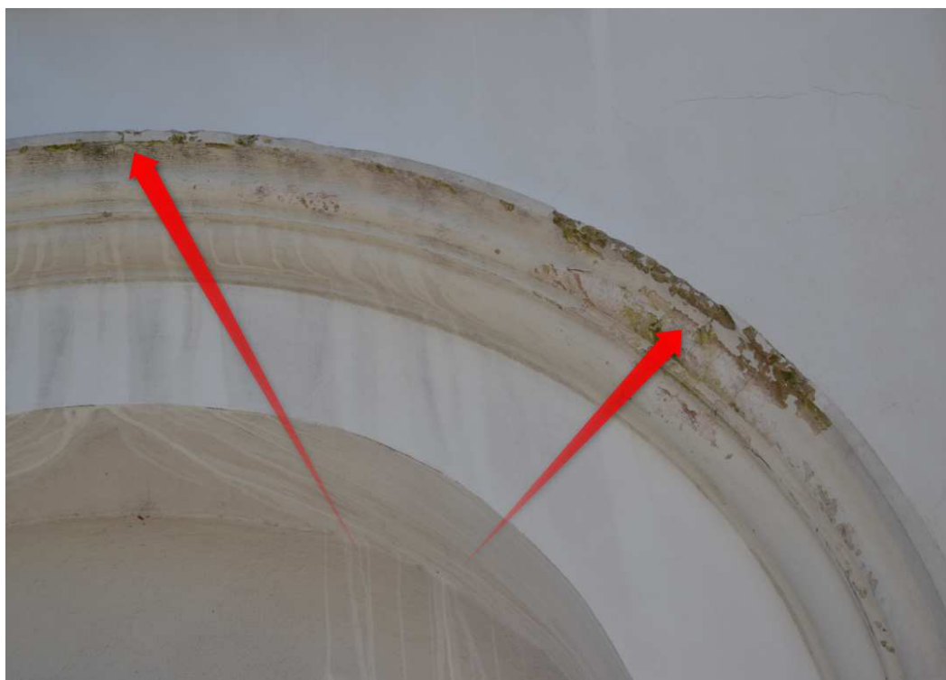
Fot. 14 Ubytki w łukach wieńczących dzwonnicy. Odspojona farba.
