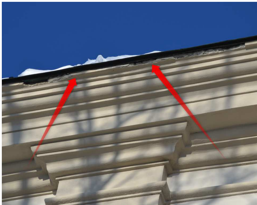
Fot. 11 Ubytki w gzymsie w górnych partiach kościoła. Łuszcząca i odspojona farba.
