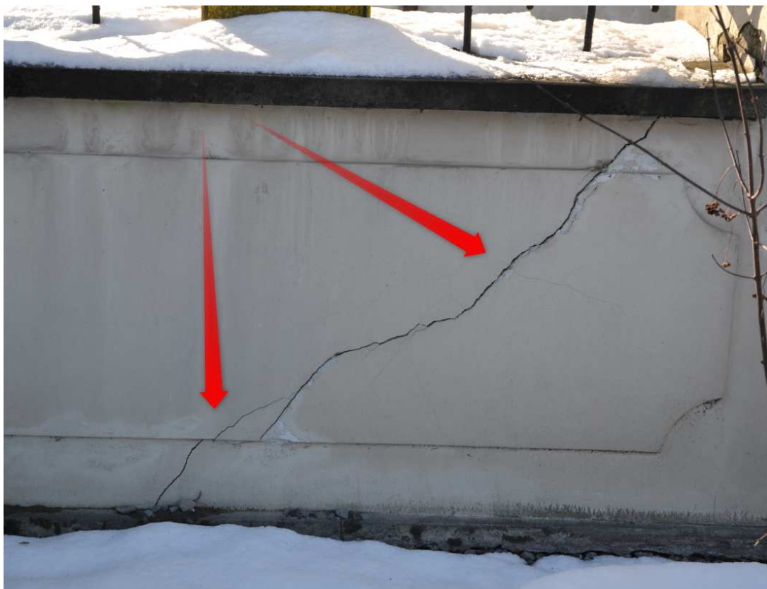
Fot. 21 Zarysowania i odparzenia tynków dolnych częściach ogrodzenia. Odspojona farba.
