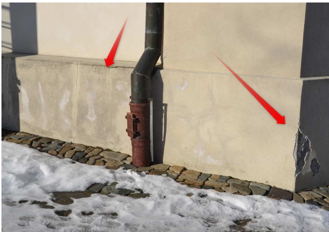
Fot. 6 Wysolenia, zarysowania i odparzenia tynków cokołu kościoła
