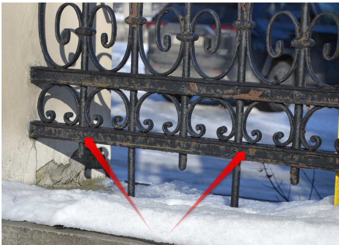
Fot. 20 Widoczne ogniska korozji i łuszczącej farby na metalowych przęsłach ogrodzenia.
