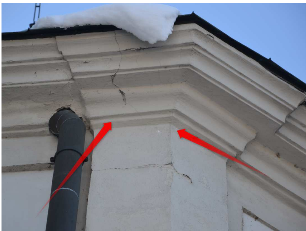
Fot. 10 Zarysowania tynków w górnych partiach kościoła. Łuszcząca i odspojona farba.
