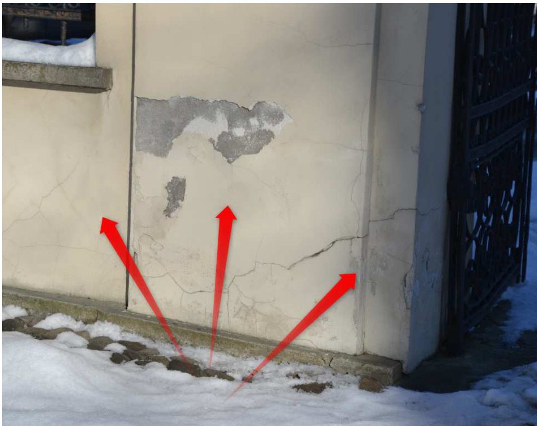
Fot. 19 Zarysowania i odparzenia tynków dolnych częściach ogrodzenia. Odspojona farba.
