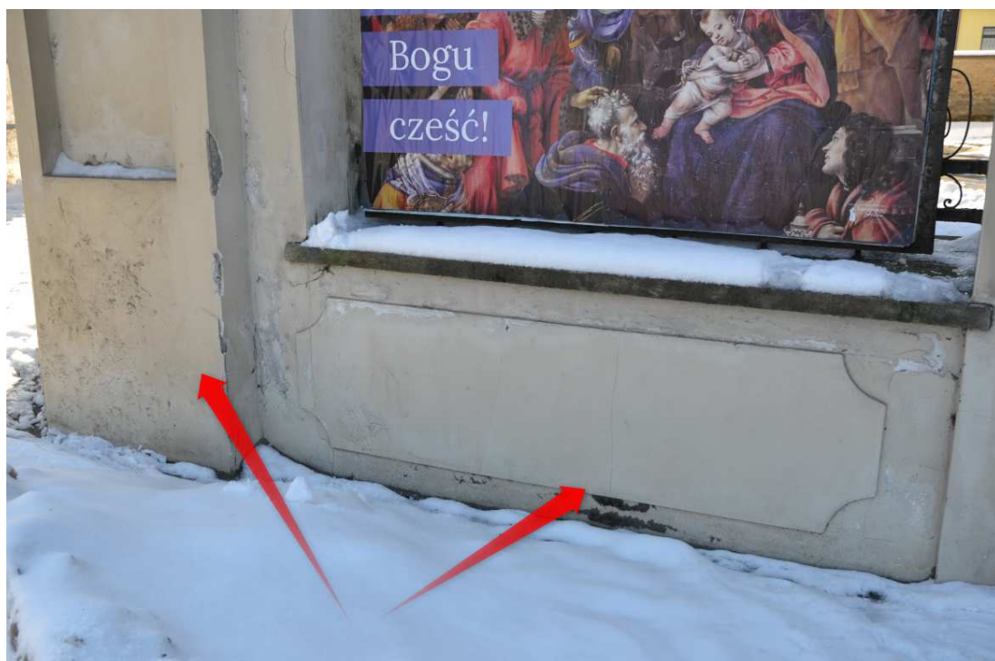
Fot. 17 Zarysowania i odparzenia tynków dolnych części ogrodzenia. Odspojona farba.
