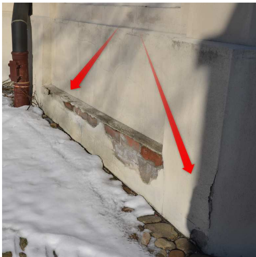
Fot. 7 Zarysowania i odparzenia tynków cokołu kościoła
