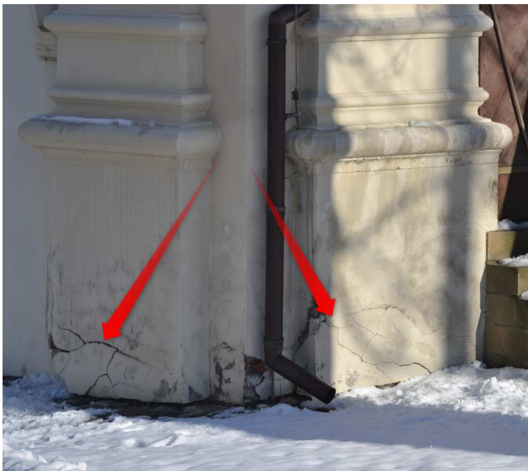
Fot. 13 Ubytki i odspojenia tynku w pilastrze dzwonnicy. Odspojona farba.
